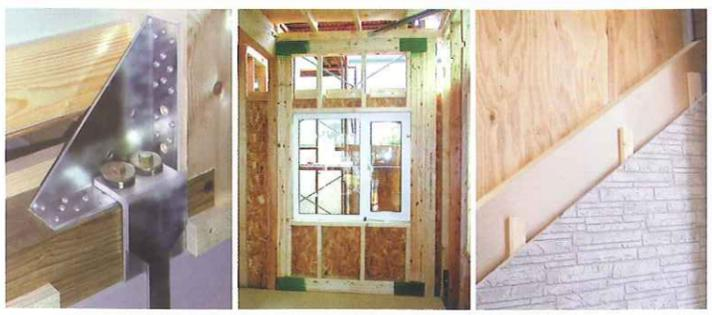
シェイクブロック耐震金物 J-耐震開口フレーム 構造用合板
